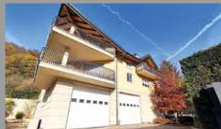
CADINE villa singola con verde in zona artigianale: piano terra di 400 mq con magazzino e uffici, piano primo 220 di abitazione e uffici, mansarda al grezzo. Info in ufficio
