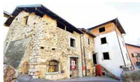
LASINO grande casa indipendente di 4 piani, totali 260 mq, da ristrutturare, cortile 40 mq e giardino 90 mq; con possibile acquisto casa adiacente. Euro 150.000
